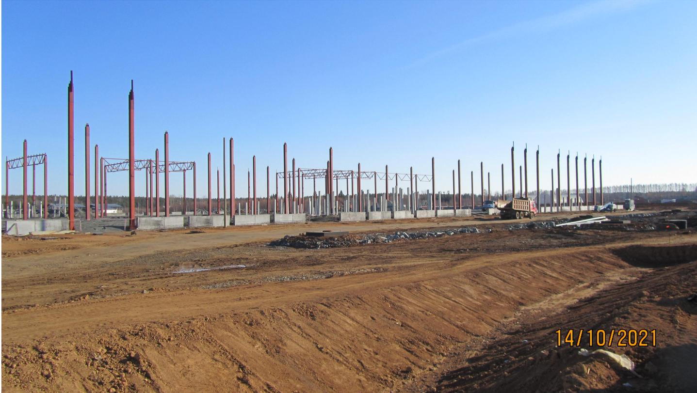
Выполнены работы по забивке свайного поля фундаментов технологического оборудования (выполнено 100%),
