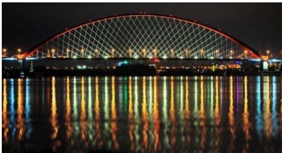
□ Бугринский мост через Обь, Новосибирск
