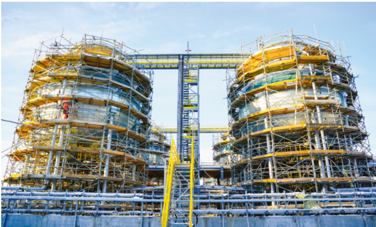
Монтаж шаровых резервуаров объемом 2400 м 3 в ЗапСибНефтехим СИБУР холдинг. Фото предоставлено компанией «Уралхиммаш»
