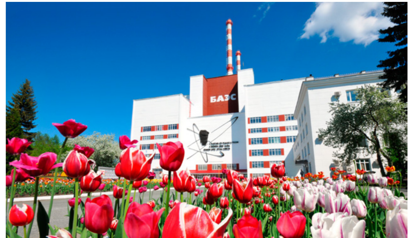
Главный корпус энергоблоков №№ 1 и 2 (АМБ-100, АМБ-200) Белоярской АЭС. Фото предоставлено Концерном «Росэнергоатом», http://stock.rosenergoatom.ru/
