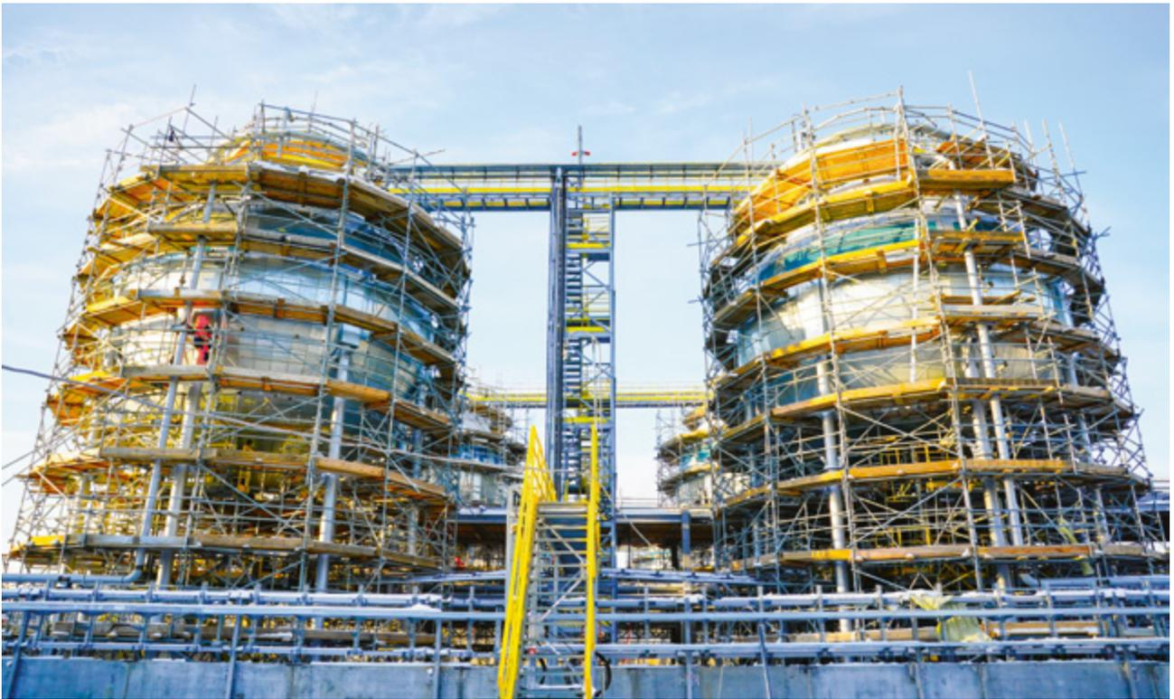
Монтаж шаровых резервуаров объемом 2400 м<sup>3</sup> в ЗапСибНефтехим СИБУР холдинг.
